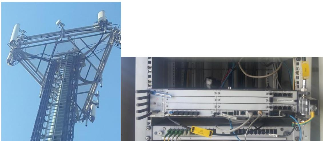
Figura 29 – eNode-B Huawei (antena exterior e unidade interior).
