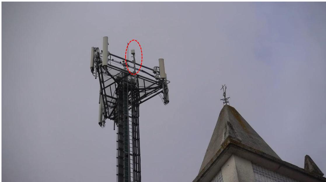
**Figura 36 – Antena do eNode-B da Huawei instalado na torre da MEO.**
