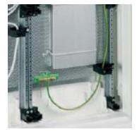
O ATE contém obrigatoriamente o Barramento Geral de Terras das ITED (BGT). As ligações das terras de protecção das infra-estruturas são efectuadas no BGT. O BGT é por sua vez interligado ao barramento geral de terras do edifício. No caso de se adoptar a solução de fixação dos dispositivos através de perfis metálicos, estes devem ser ligados ao BGT.
