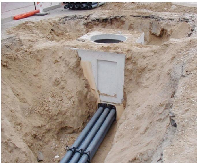
Sempre que seja necessário efectuar a união entre tubos, esta deve ser executada através de dispositivos de abocardamento macho-fêmea e utilizadas colas adequadas, garantindo assim uma união perfeita e uma boa estanquicidade da tubagem a estabelecer.
