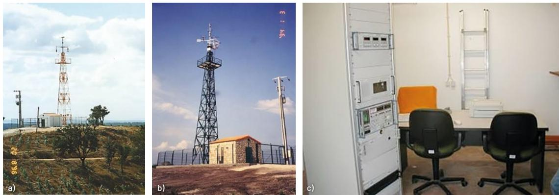
**FIGURA 14 – Estações remotas do SINCRER. a) Estação com radiogoniometria para VHF e UHF. b) Estação com antenas diretivas rotativas. c) Hardware no interior de uma estação do SINCRER**
