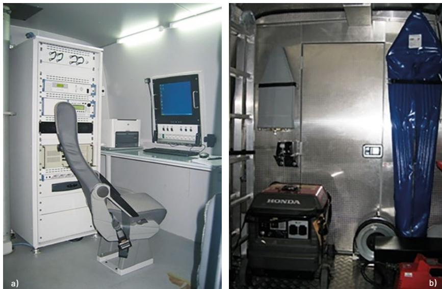
**FIGURA 17 – Estação móvel de monitorização e controlo do espectro radioelétrico.**
