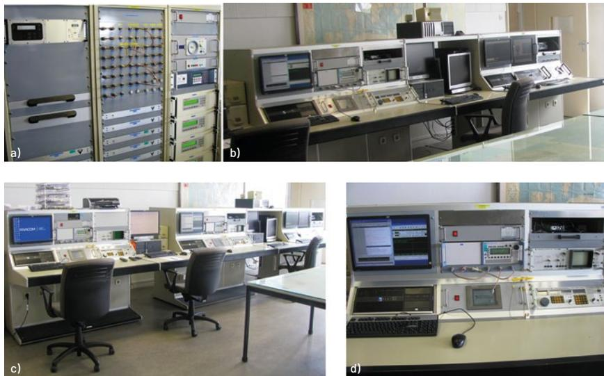
**FIGURA 10 – Sala de controlo do centro de Barcarena. a) Controlador e distribuidor de antenas. b) e c) Posições de monitorização. d) Pormenor de uma posição de monitorização**
