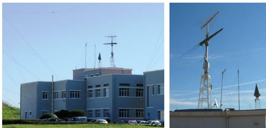
**FIGURA 9 – Parque de antenas ativas de receção, instaladas no centro de Barcarena para a monitorização e controlo do espectro radioelétrico, nas faixas de HF, VHF e UHF**
