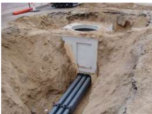
5.5 - Fotografia de uma vala técnica com a interligação de tubagem numa câmara de visita
