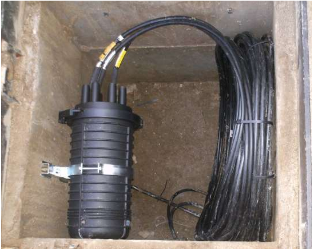
5.12 - Exemplo da instalação de uma junta de fibras óticas do tipo torpedo, no interior de uma caixa do tipo CVR1
