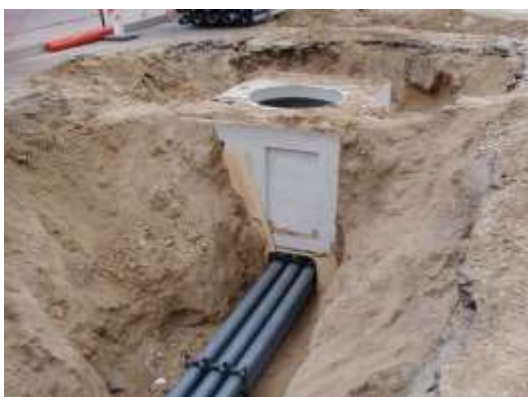
5.5 - Fotografia de uma vala técnica com a interligação de tubagem numa câmara de visita
