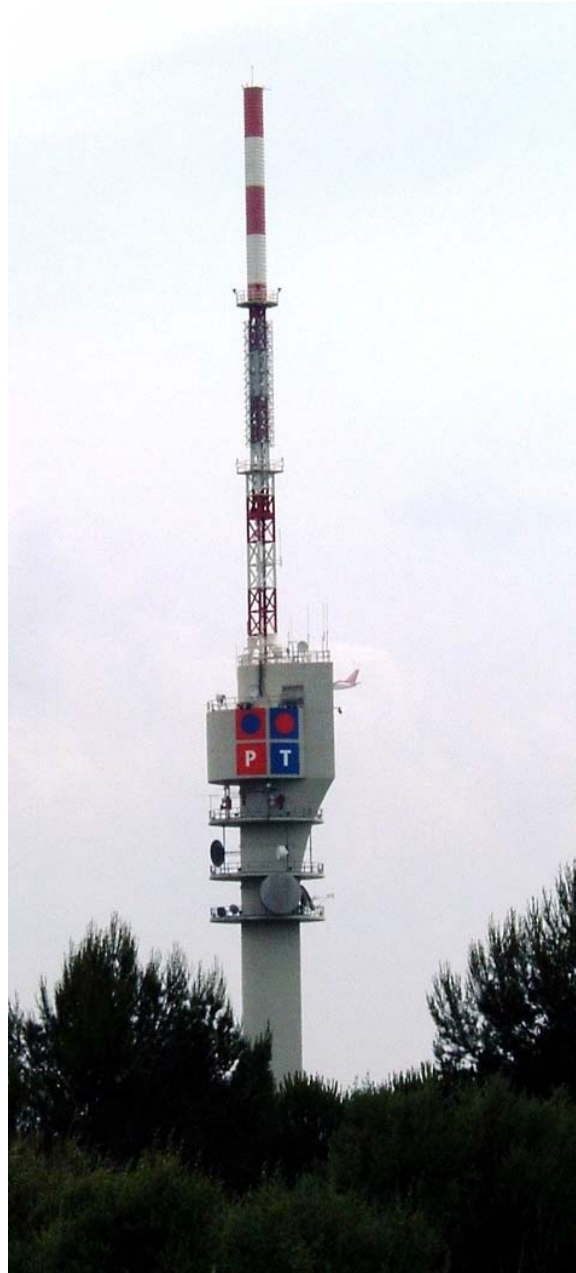
Figura 3. Torre da Portugal Telecom em Monsanto (Lisboa).
