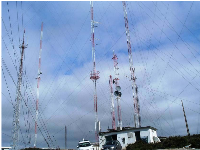
Figura 1. Montejunto - Local com elevada densidade de meios rádio de elevada potência.
