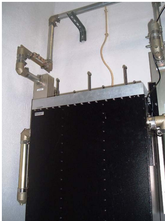
Figura 6. Filtro de tripla cavidade (3 pólos), do tipo passa-banda, para rejeição de radiações não-essenciais.
