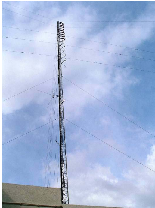
Figura 55. Torre onde se encontravam instalados ambos os sistemas radiantes das estações de radiodifusão envolvidas no produto de intermodulação.
